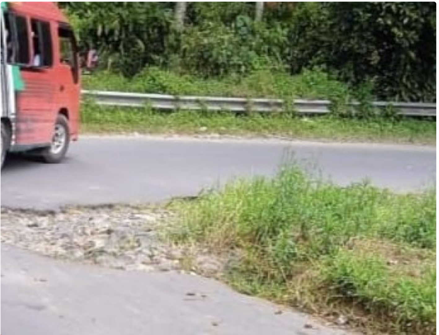
Jalan Provinsi ke Pelabuhan Penyeberangan Tigaras
